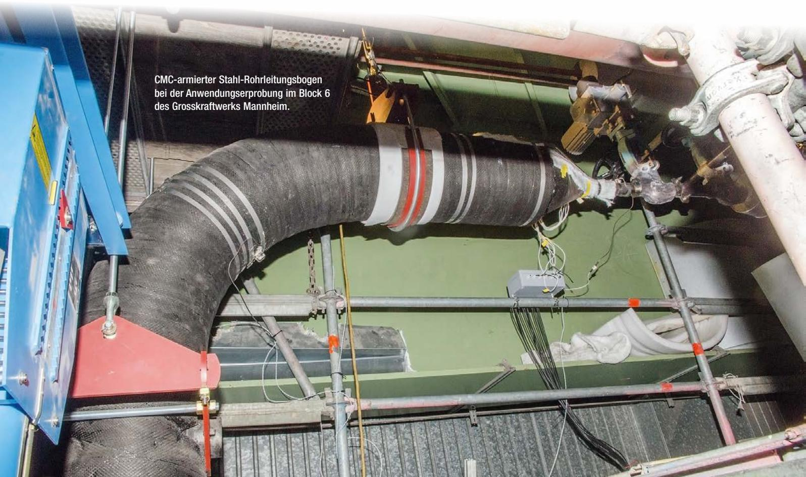
CMC-armierter Stahl-Rohrleitungsbogen bei der Anwendungserprobung im Block 6 des Grosskraftwerks Mannheim.
